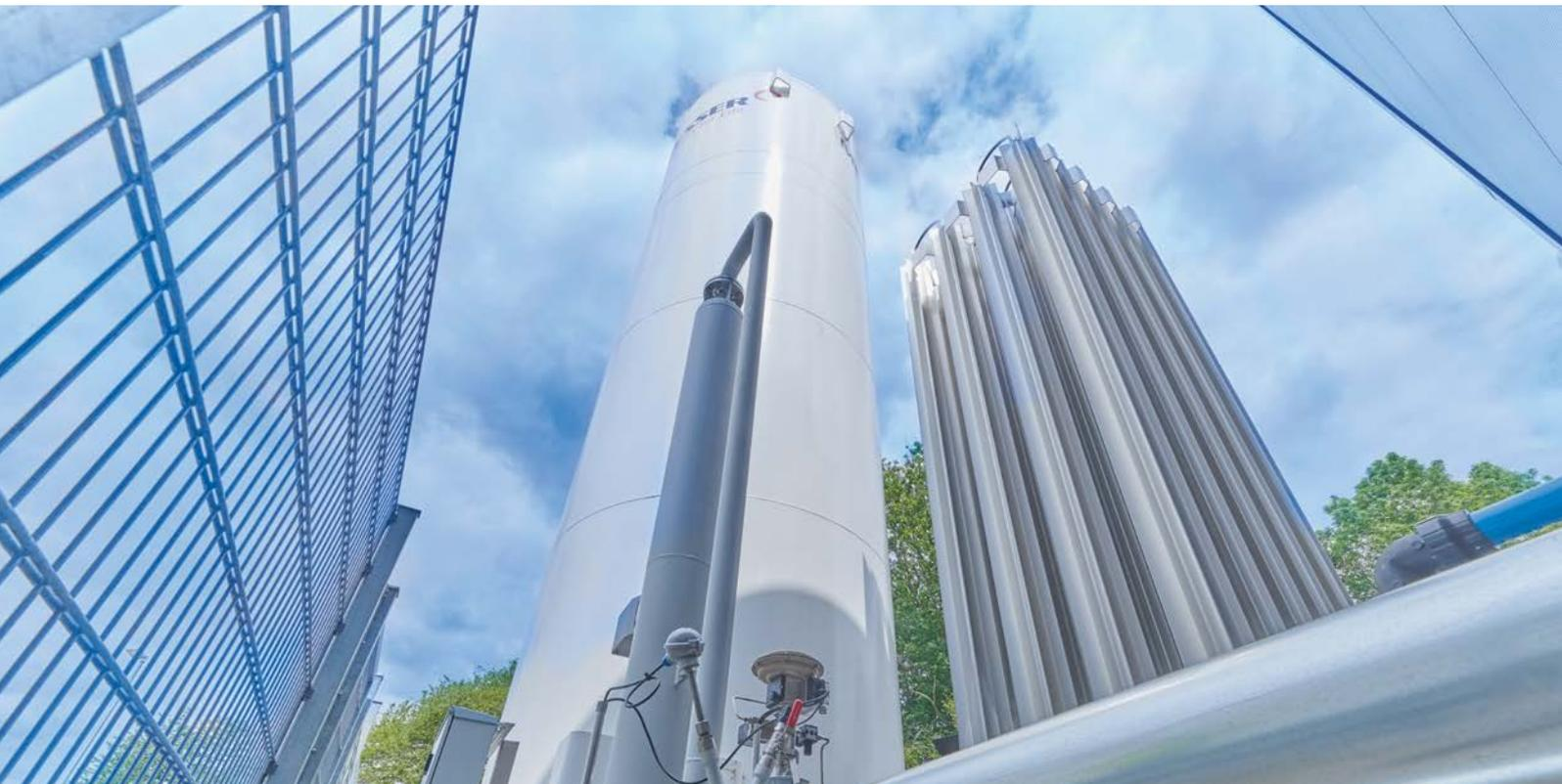
Mit der Kälte verflüssigter Gase aus dem Eco-Vap-Verdampfer arbeiten Kühlsysteme umweltfreundlich und effizient. Viele Produktionsbetriebe nutzen Industriegase wie Stickstoff, Sauerstoff, Kohlendioxid oder Argon, die in tiefkalter, verflüssigter Form gelagert werden.
