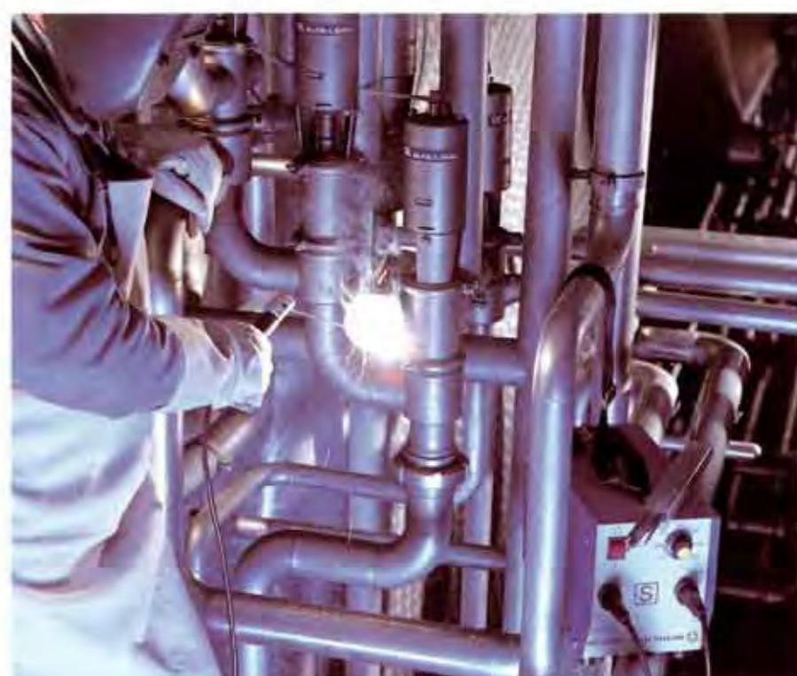
Querschnittliches Foto einer von Lichtbogen-schweißgeräten mit 7 Meter Länge produzierten und mit einem hochpräzisen Laserschneidgerät mit Inverter-Technik gefertigten
