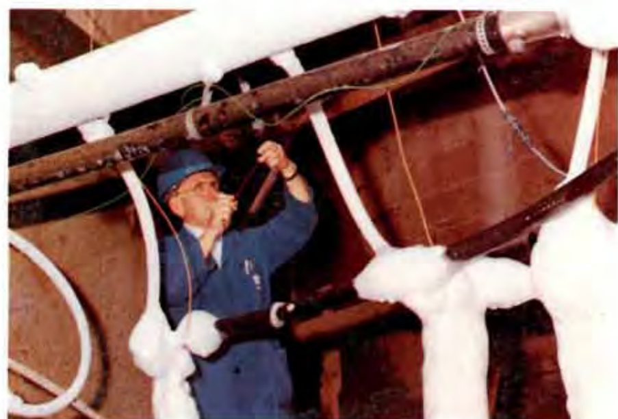
Bei Tiefbauarbeiten wie dem U-Bahnbau in Düsseldorf ist das Erdreich gefrieren mit flüssigem Stickstoff bewährte Praxis.
